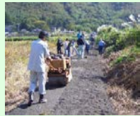
未舗装農道の舗装
