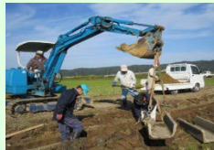
コンクリート水路の更新
