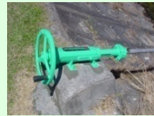
ゲート、バルブの更新
