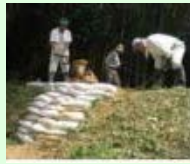
漏水箇所の補修
