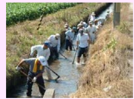
水路の泥上げ
