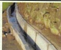
コンクリート水路の更新
