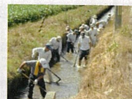
水路の泥上げ
