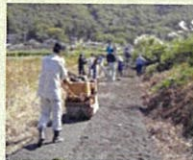
未舗装農道の舗装
