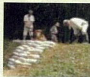
漏水箇所の補修
